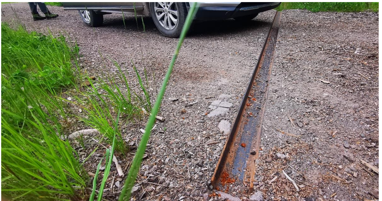
Slika 15: Za prečno odvodnjavanje uporabljajo kovinske dražnike.
