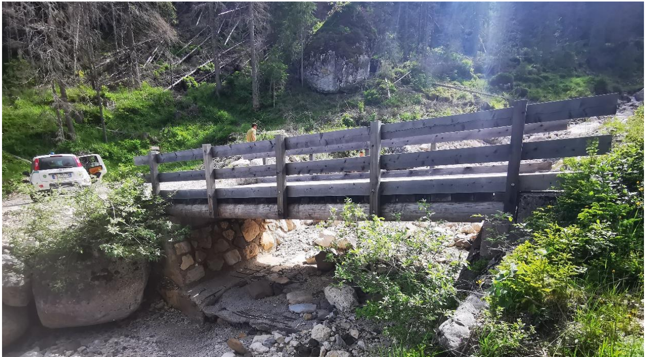
Slika 14: Izvedba mostu na gozdni cesti.
