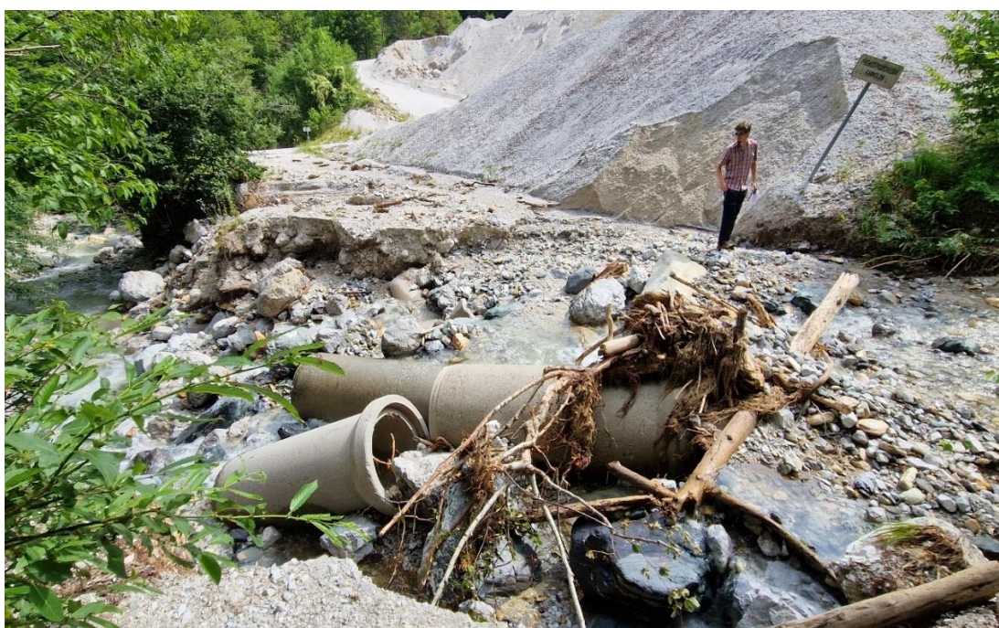
Slika 2: Krajši odsek gozdne ceste, ki jo je odnesel hudournik zaradi zamašitve dvojnega cevnega propusta (U. Vilhar).
