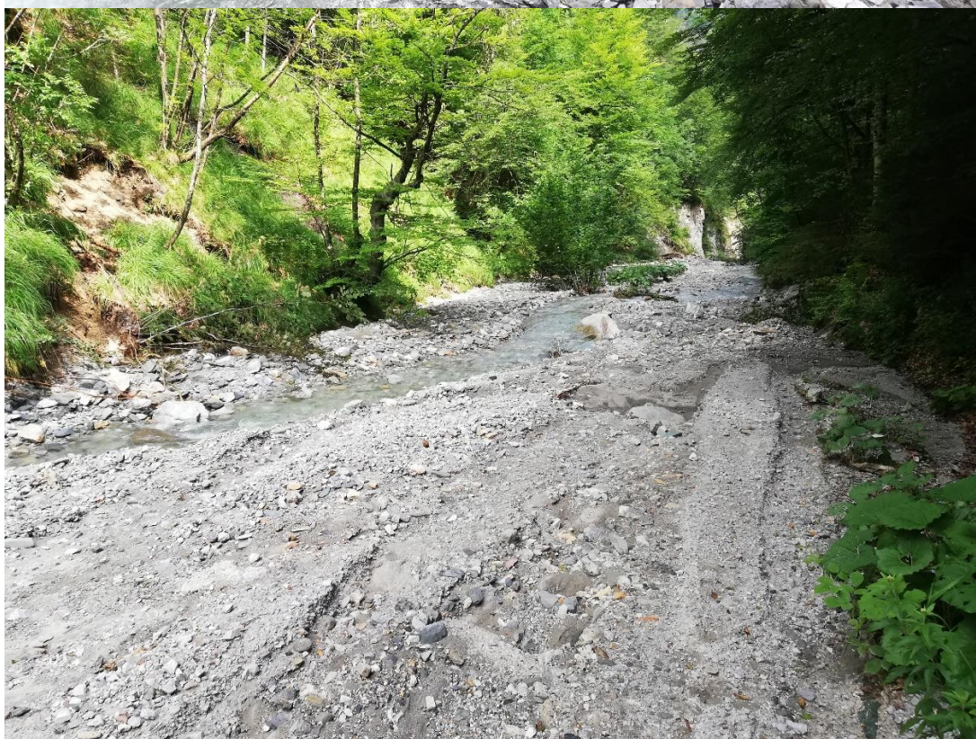
Slika 3: Hudournik Zala je zaradi zamašenega mostu (zgoraj) spremenil svoj tok in ob tem popolnoma uničil 100 m dolg odsek gozdne ceste gorvodno (spodaj). (J. Saražin)
