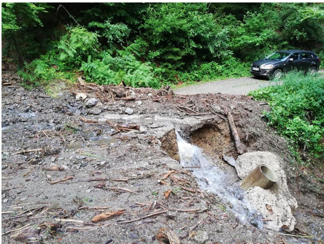
Slika 10: Sosednja gozdna cesta pa je še čakala na sanacijo. Nezaustojno utrjeni iztoki in okolica cevnih prepustov so pogosto rezultirali v poškodovanju ali izpadu zadnjega cevnega prepusta (J. Saražin).
