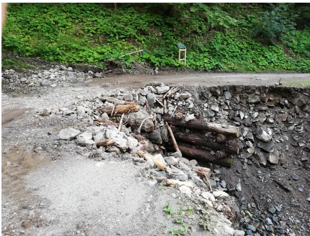
Slika 16: Zasilno vzpostavljena prevoznost prometnice za osebna in intervencijska vozila, po tem, ko je drobirski tok odnesel lesen most. Gozdne prometnice so bile marsikje ključne za dostop interventnih služb, tako do kmetij, kakor tudi do naselij, kjer so bile javne prometnice neprevozne. (J. Saražin)
