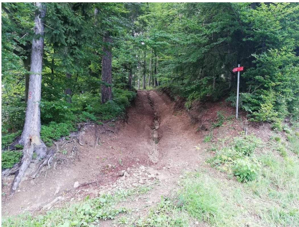
Slika 11: Jarkasta erozija na gozdni vlaki (J. Saražin)
