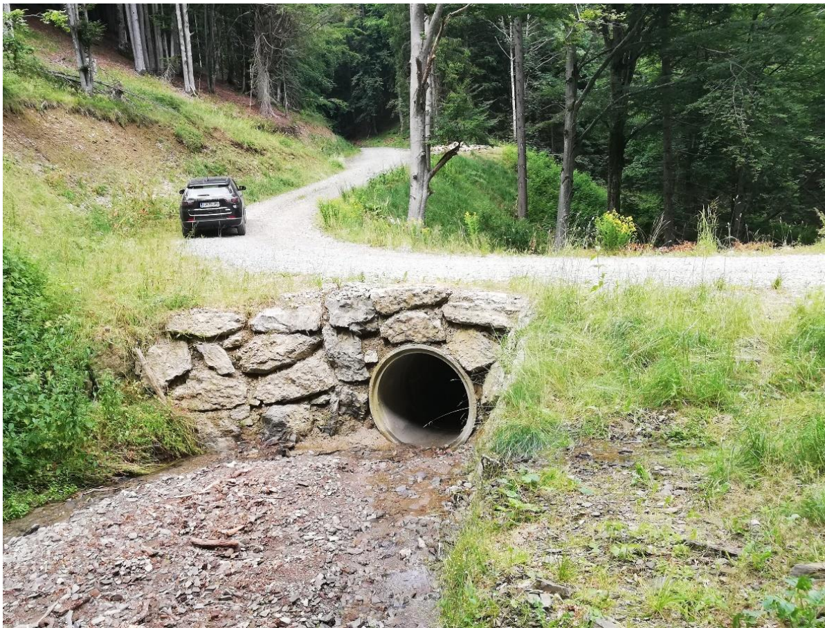
Slika 44: Cevni prepust z urejenim vtokom (Saražin J.)
