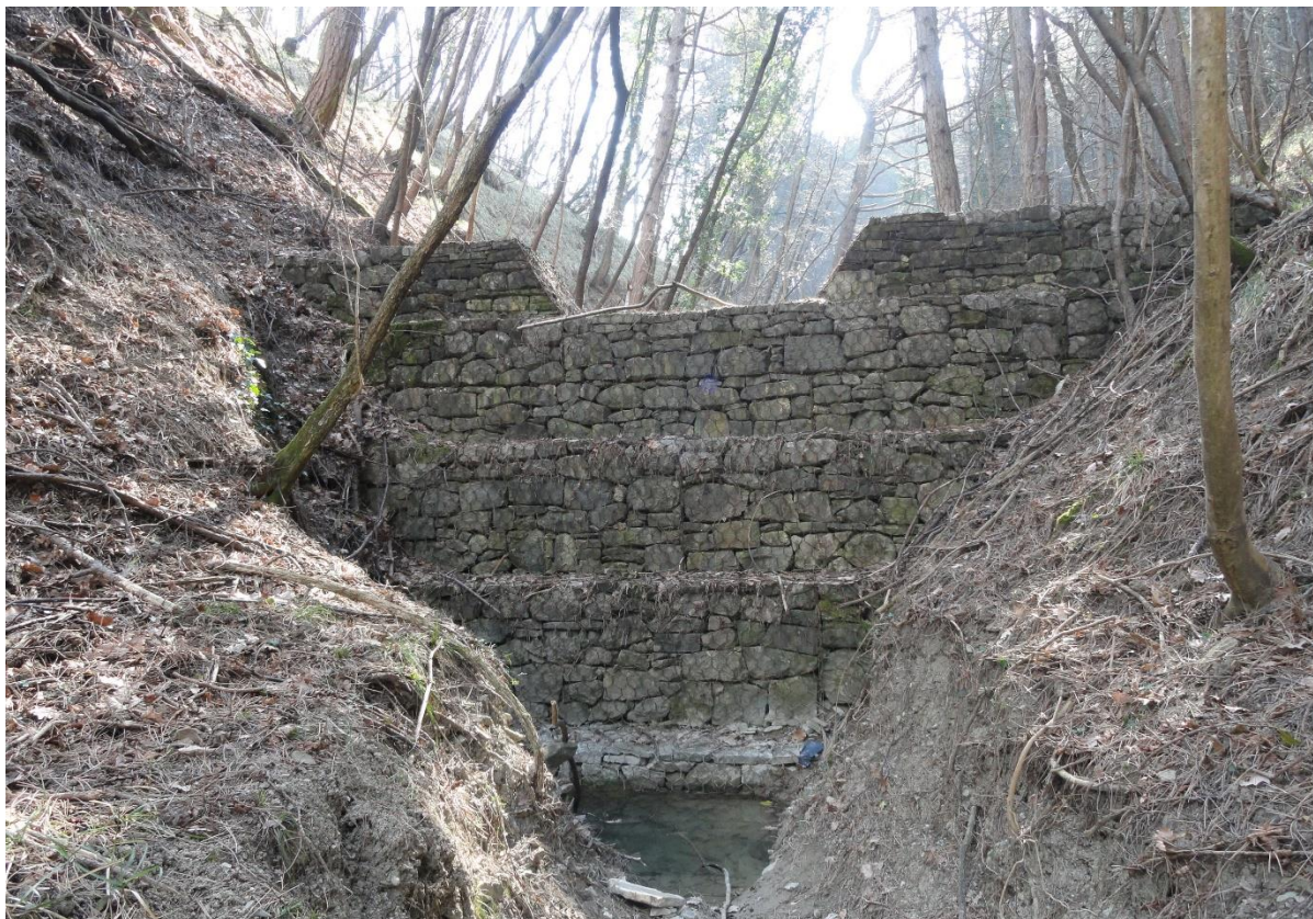
Slika 25: Pregrada iz žičnih košar na območju Ospa (Saražin J.)
