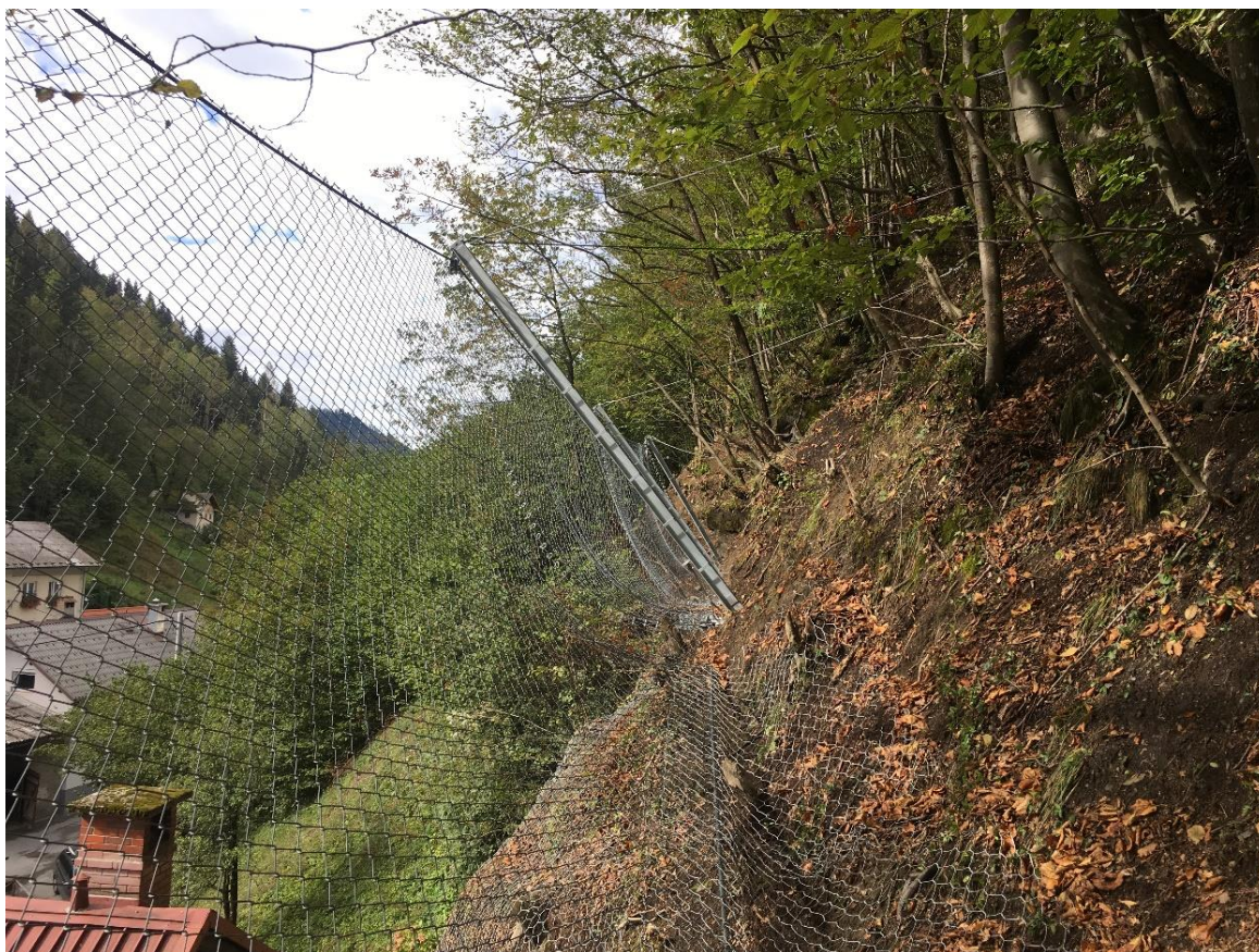
Slika 48: Podajno lovilni sistemi Geobruigg GBE-1000A pri Podbrdu (Cej T.)
