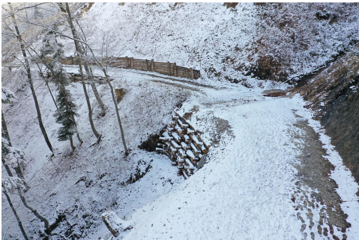
Slika 38: Betonska mulda na gozdni cesti podprta z leseno kašto (Saražin J.)
