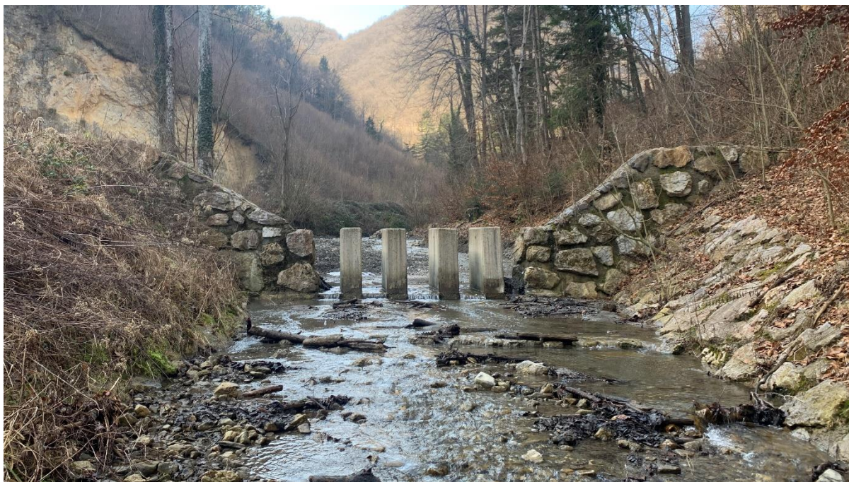
Slika 31: Prebiralna pregrada na Bistrem Grabnu (Kobal M.)
