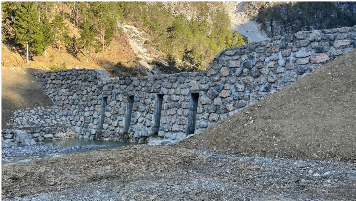
Slika 32: Večja prebiralna pregrada na Belci (Kobal M.)
