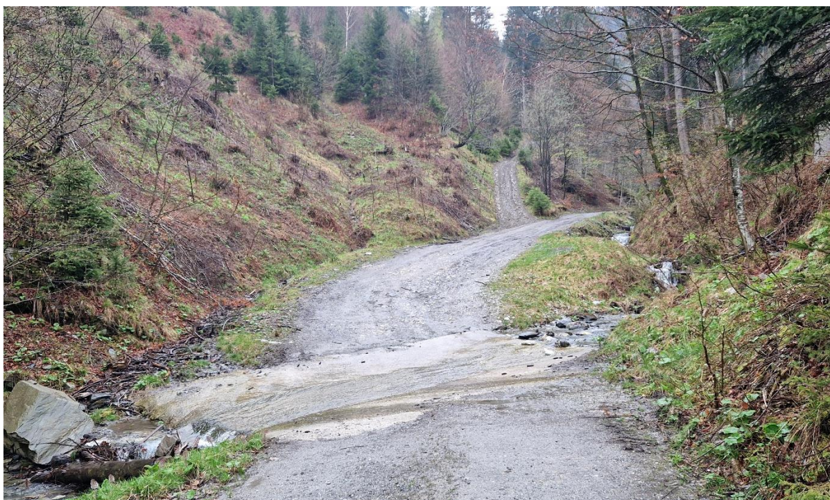
Slika 40: Utrjena mulda na gozdni cesti (Vilhar U.)
