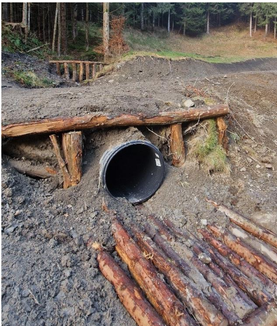
Slika 43: Cevni prepust z urejenim vtokom in iztokom z elementi iz lesenih oblic (Vilhar U.)
