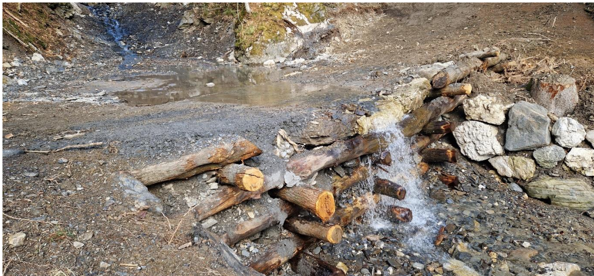
Slika 17: Lesena kašta omogoča prečkanje hudournika z gozdno vlako ( Vilhar U.)
