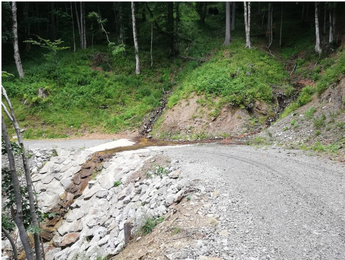
Slika 39: Utrjena mulda na gozdni cesti, podprta s kamnom v betonu (Saražin J.)
