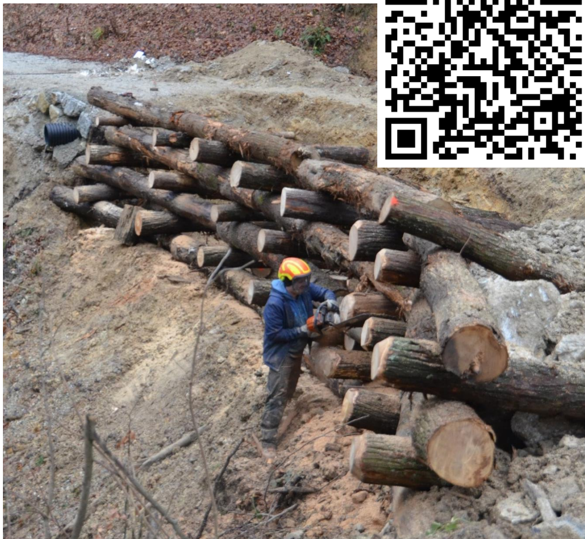
Slika 5: Izdelava lesene kašte v dolini reke Zale, občina Železniki (Dovečar M.)
