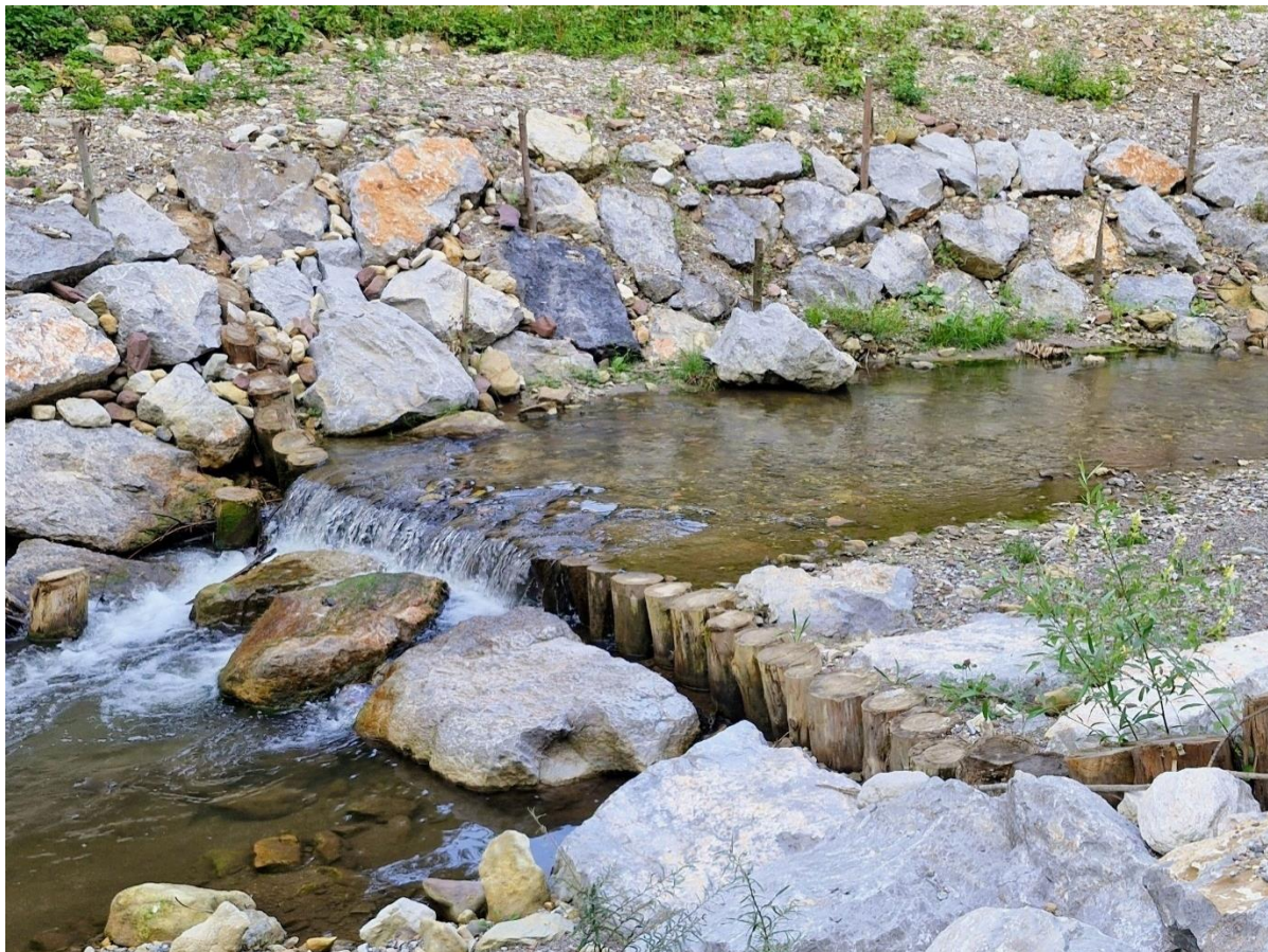
Slika 21: Prag iz lesenih oblic na Ločnici (Dovečar M.)
