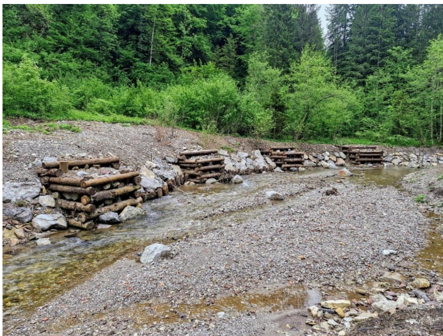
Slika 51: Jezbice na Ločnici (Dovečar M.)
