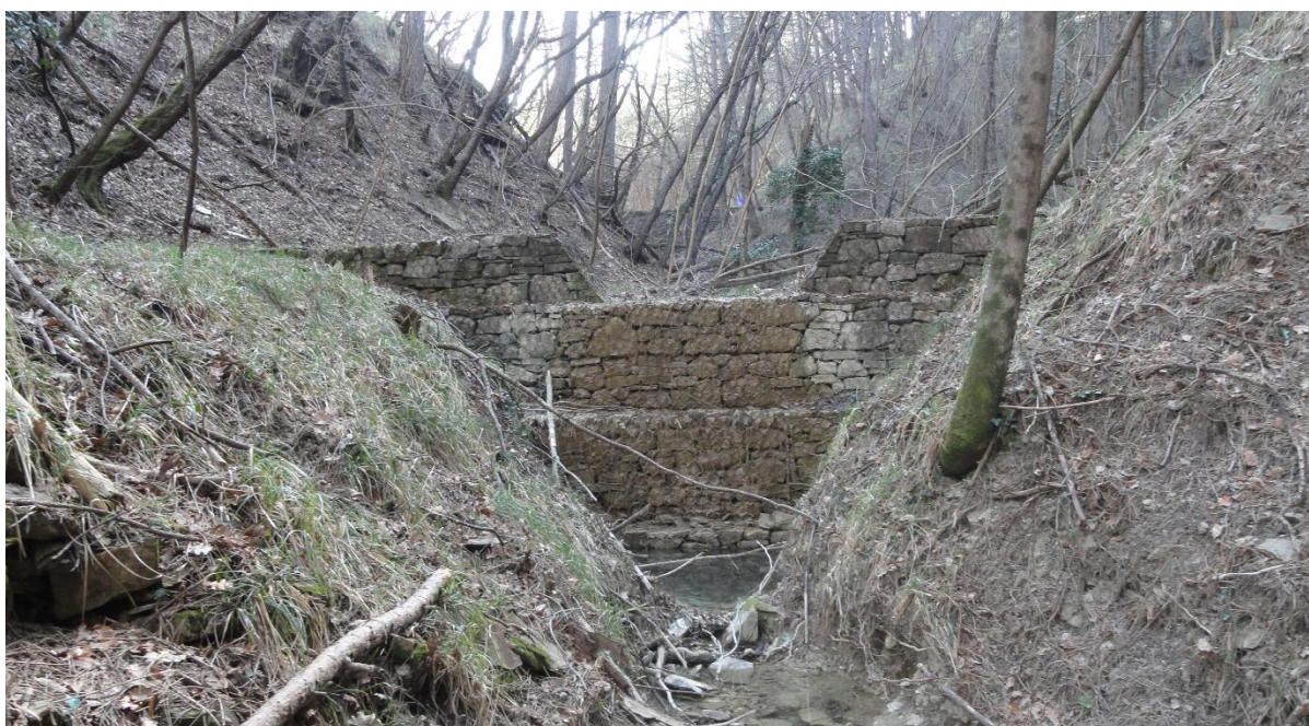
Slika 26: Pregrada iz žičnih košar na območju Ospa (Saražin J.)
