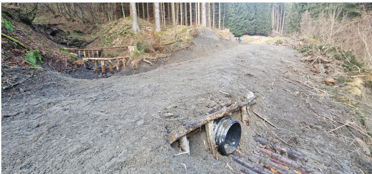
Slika 45: Cevni prepust s uvajalnimi prebiralnimi grabljami (Vilhar U.)
