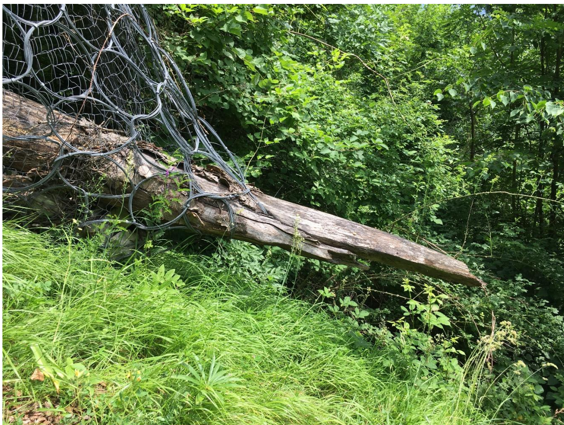
Slika 49: Podajno lovilni sistem Geobruigg RXI-025 je uspešno ulovil večji hlod pri Železnikih (Cej T.)
