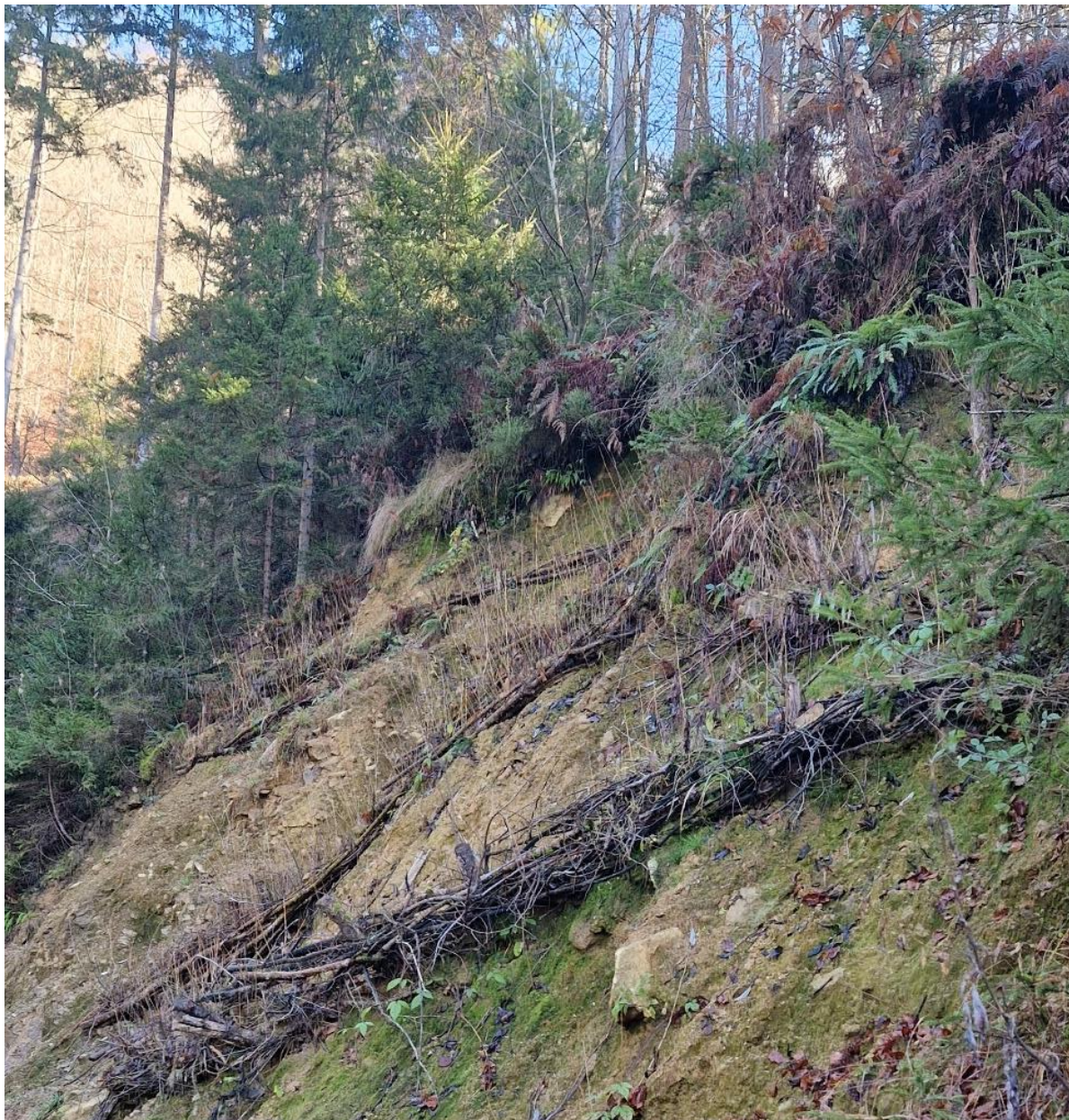
Slika 2: Vrbovi popleti, sidrani s količki jelše, na območju Železnikov (Vilhar U.)
