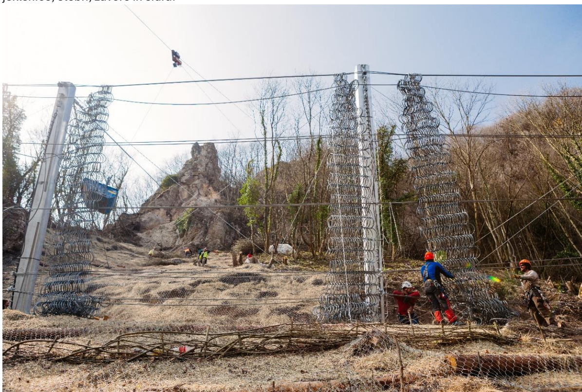
Slika 47: Podajno lovilni sistem Geobrugg RXE-8000 nad tovarno Lafarge – Zagorje (Avanzo P.)
