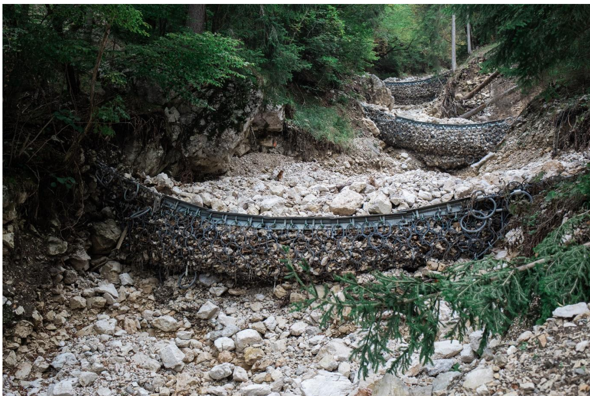
Slika 22: Sistem mrežnih hudourniških pregrad Geobrugg v Brezovškovem grabnu pod Krvavcem (Avanzo P.)
