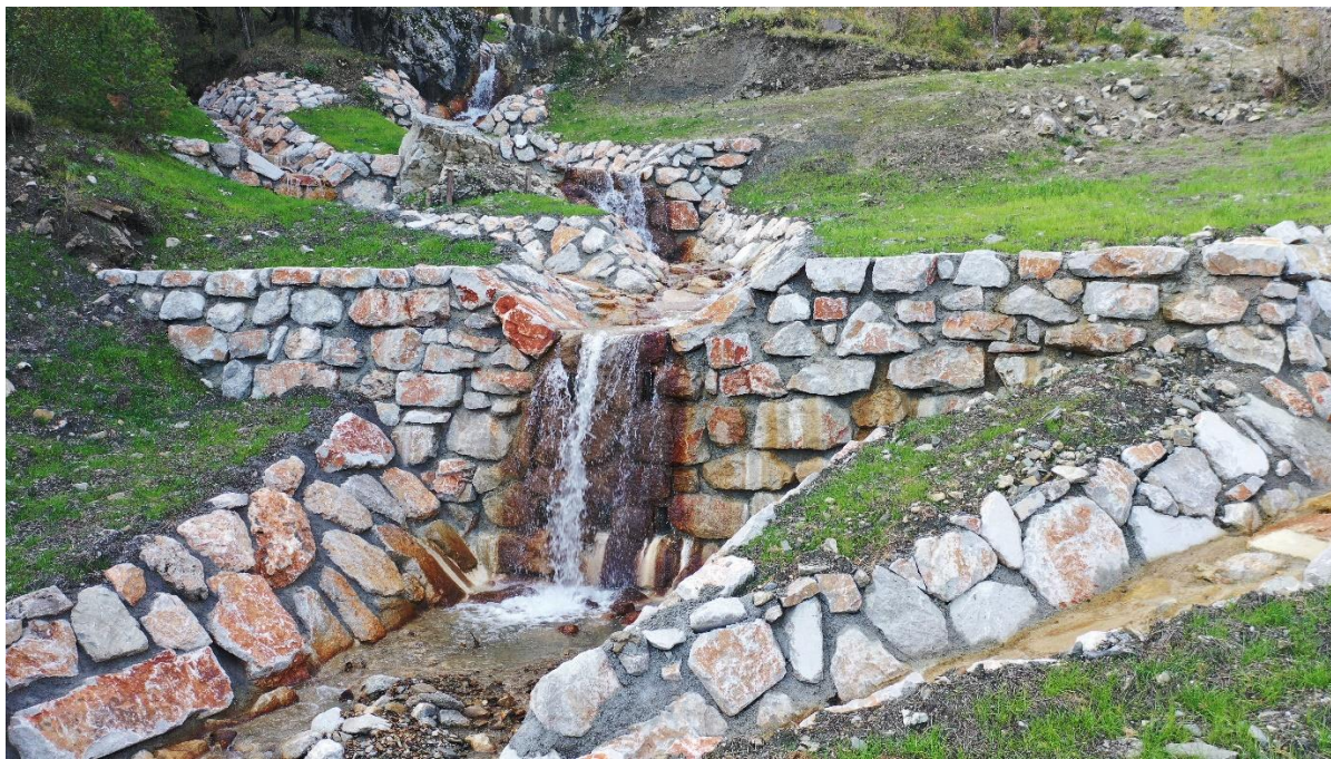
Slika 27: Sistem ustalitvenih pregrad in kanalet na območju plazu Slano blato (Papež J.)
