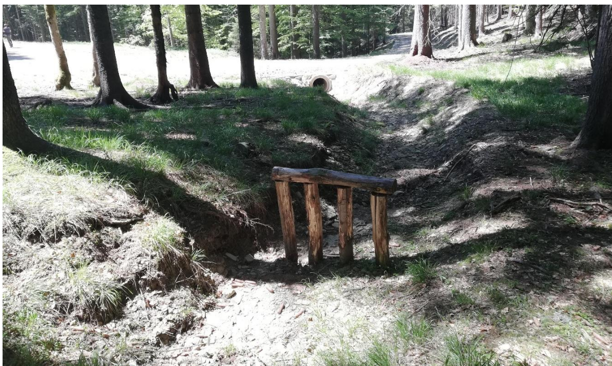
Slika 37: Manjše prebiralne grablje pred cevnim prepustom (Saražin J.)
