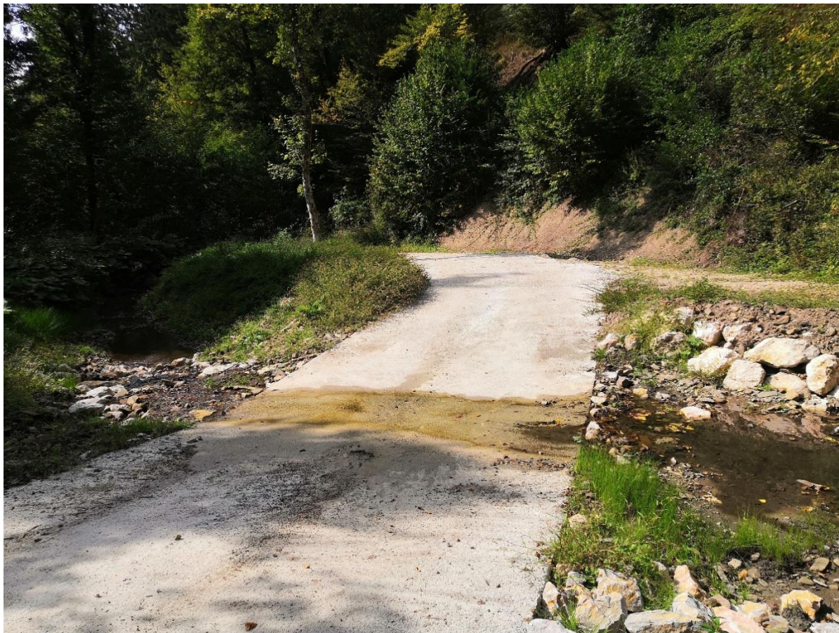
Slika 41: Armirano-betonska mulda na gozdni cesti (Benčina A.)
