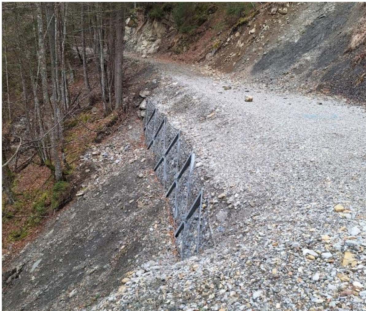
Slika 15: Mrežnati »dežniki« stabilizirajo nasipno brežino na gozdni cesti v bližini Beljaka (Pristovnik D.)
