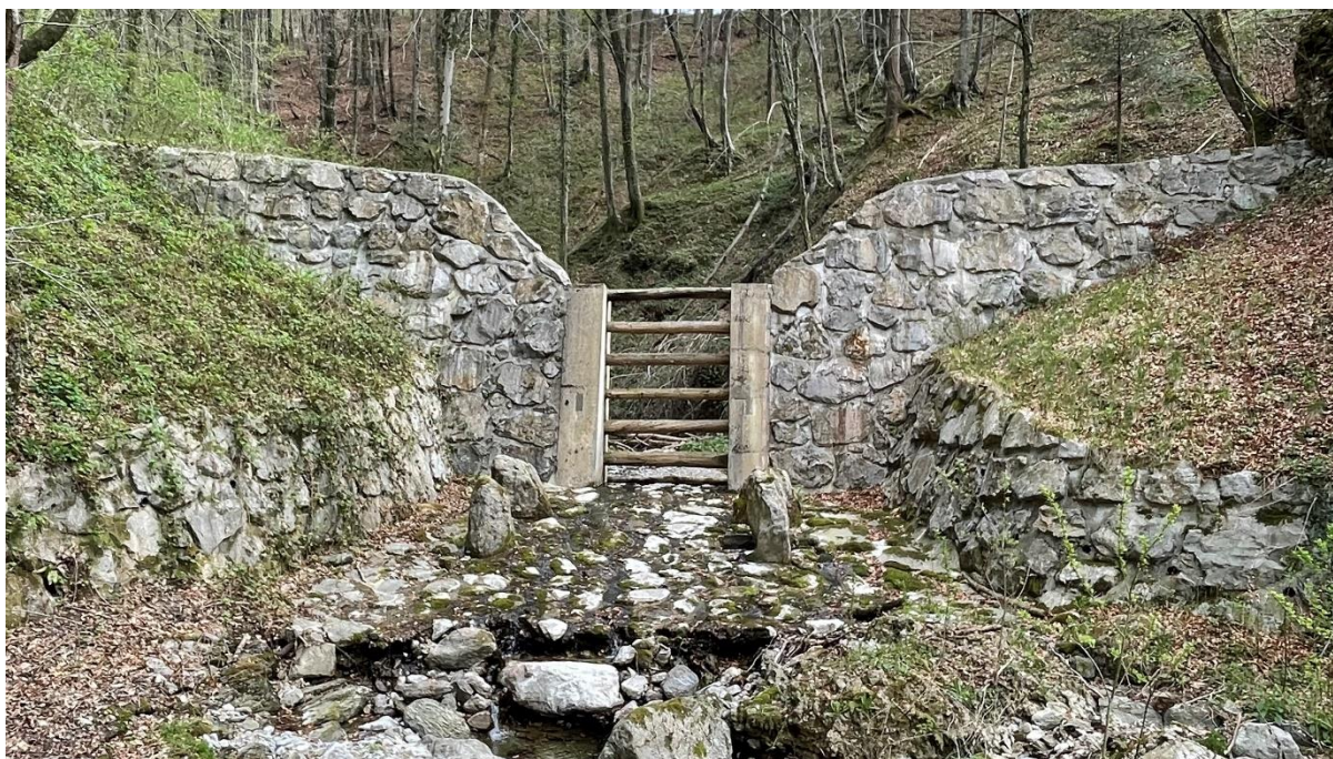
Slika 33: Prebiralna pregrada na hudourniku Kostanjevica (Kobal M.)
