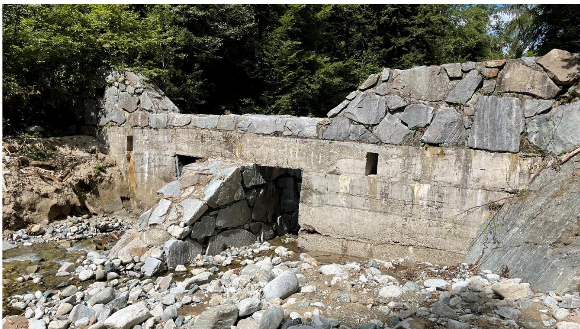
Slika 34: Prebiralna pregrada na Radoljni (Kobal M.)
