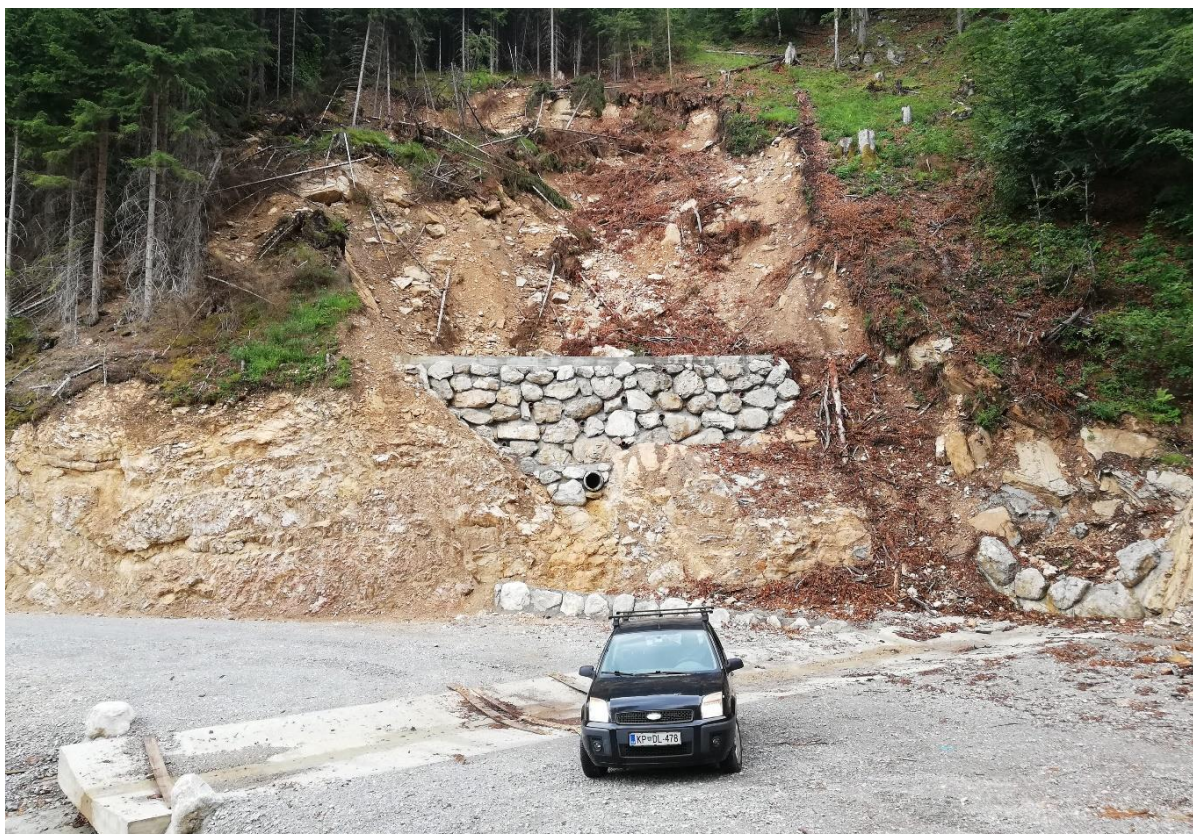
Slika 13: Kamen v betonu kot sanacijske rešitve erozijskega žarišča nad gozdno cesto na Jezerskem (Saražin J.)
