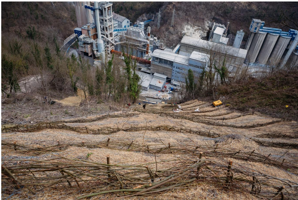
Slika 3: Kombinacija, kokosove mreže, vrbovega popleta in kovinske mreže nad tovarno Lafarge - Zagorje (Avanzo P.)
