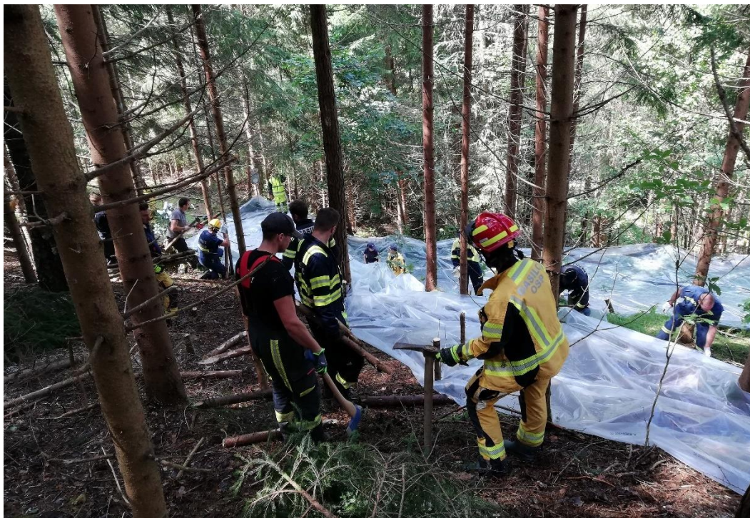
Slika 17: Kljub obilici intervencij v samih naseljih, so interventne službe izvajale nujne ukrepe tudi v gozdnem prostoru. Koroški gasilci, so s pomočjo gasilcev Obalne gasilske zveze Koper izvedli prekrivanje razpoke nad več kot hektar velikemu zemeljskem plazju, ki je ogrožal stanovanjske objekte v Črni na Koroškem. (J. Saražin)
