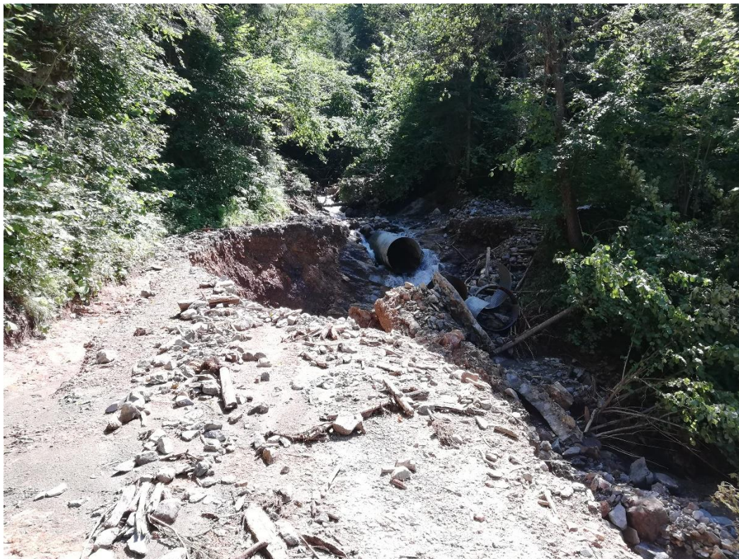
Slika 12: Hujše poškodbe gozdne ceste nad Črno na Koroškem, kot posledica zamašenega velikega cevnega prepusta (J. Saražin).
