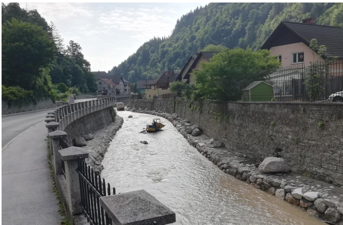
Slika 1: Takoj po ujmah so v središču Železnikov hiteli z nadaljevanjem urejanja struge Selške Sore – EU projekt (J. Saražin).
