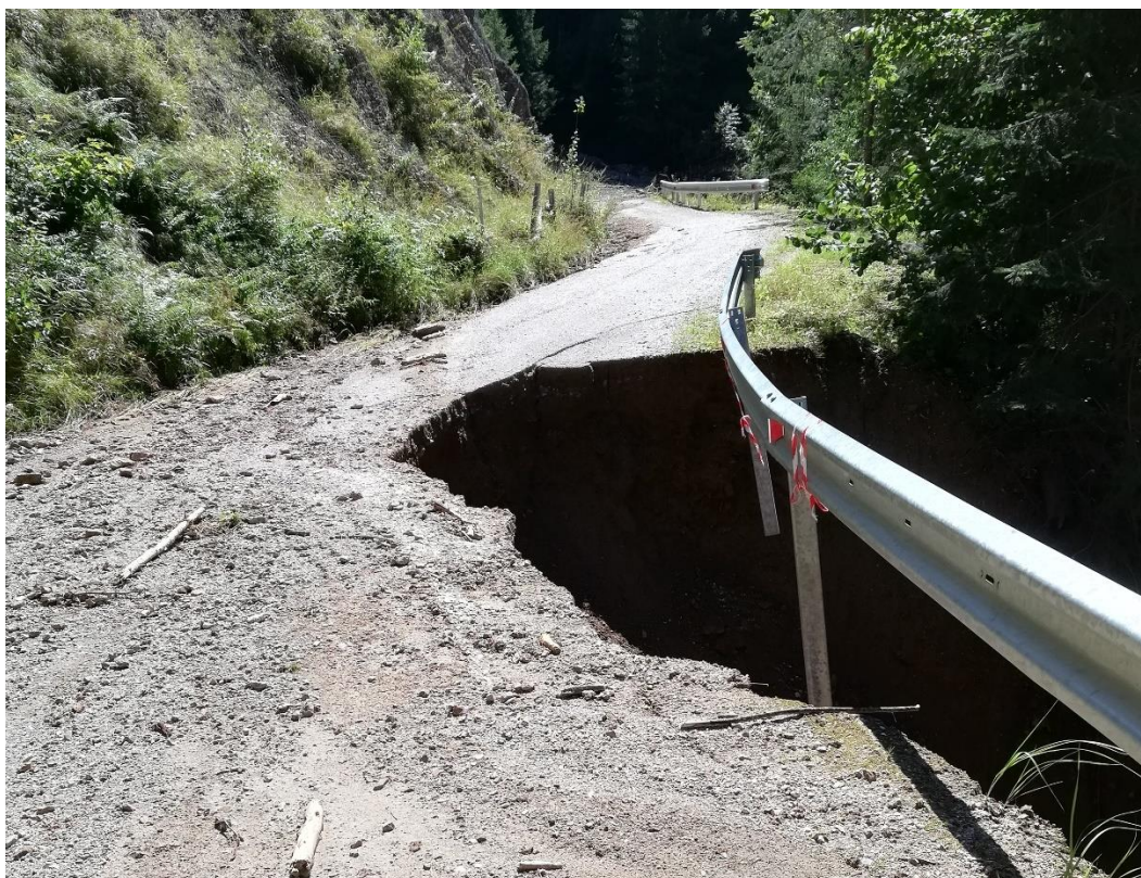
Slika 15: Večji usad na gozdni cesti (J. Saražin)
