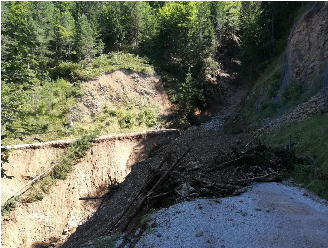
Slika 13: Drobirski tok je pri prečkanju gozdne ceste povzročil veliko erozijsko jedro (J. Saražin)
