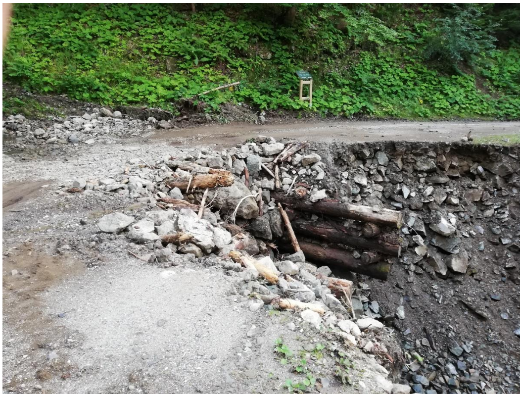
Slika 16: Zasilno vzpostavljena prevoznost prometnice za osebna in intervencijska vozila, po tem, ko je drobirski tok odnesel lesen most. Gozdne prometnice so bile marsikje ključne za dostop interventnih služb, tako do kmetij, kakor tudi do naselij, kjer so bile javne prometnice neprevozne. (J. Saražin)
