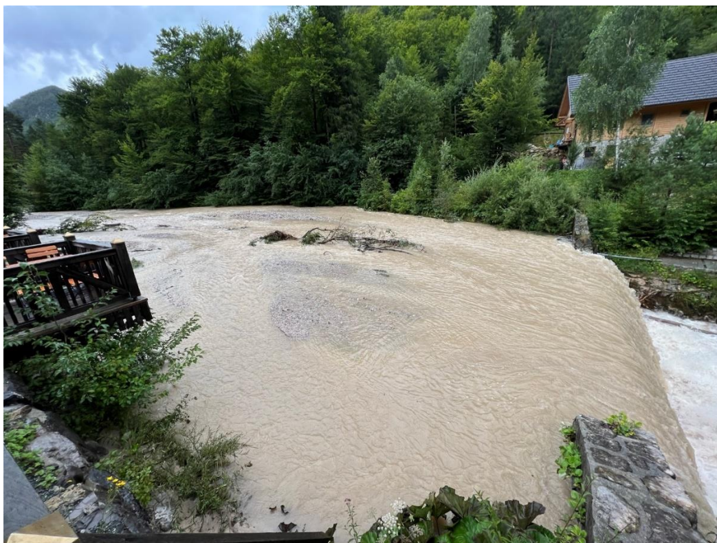
Slika 7: Zaplavna pregrada pred jezerom Završnica se je do vrha zapolnila s hudourniškimi nanosi. Pred neurjem je bilo za zaplavno pregrado jezerce (foto: A. Marinšek).
