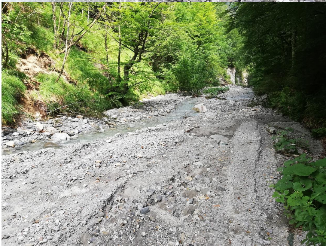
Slika 3: Hudournik Zala je zaradi zamašenega mostu (zgoraj) spremenil svoj potek in ob tem popolnoma uničil 100 m dolg odsek gozdne ceste gorvodno (spodaj). (J. Saražin)
